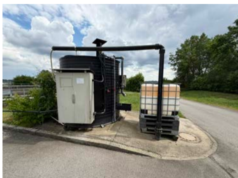
Abbildung 8: Fällmittelstation
