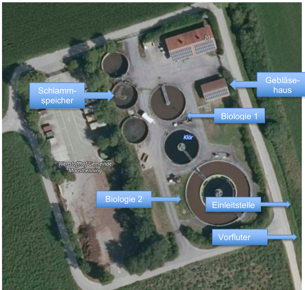
Abbildung 2: Kläranlage Moosthenning (Bayernatlas)
