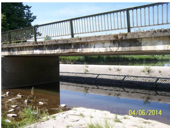
Brückenüberbau und Brückenwiderlager
