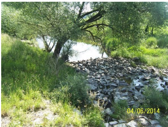
Kolksicherungsmaßnahmen aufgrund des eingetieften Vils III-Kanals (linkes Bild) und mit dem Wehr erstellte Nachbodensicherung (rechtes Bild)
