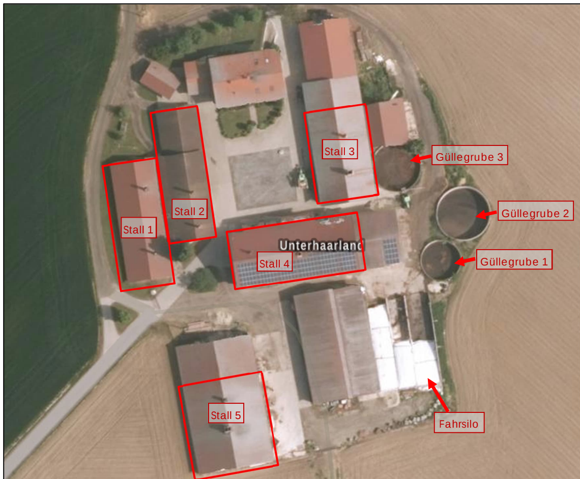
Abbildung 15: Luftbild des Bestandsbetriebs mit Kennzeichnung der Stallgebäude, Güllegruben und Fahrsilo (Quelle Luftbild: BayernAtlas, Abruf am 03.07.2024)
