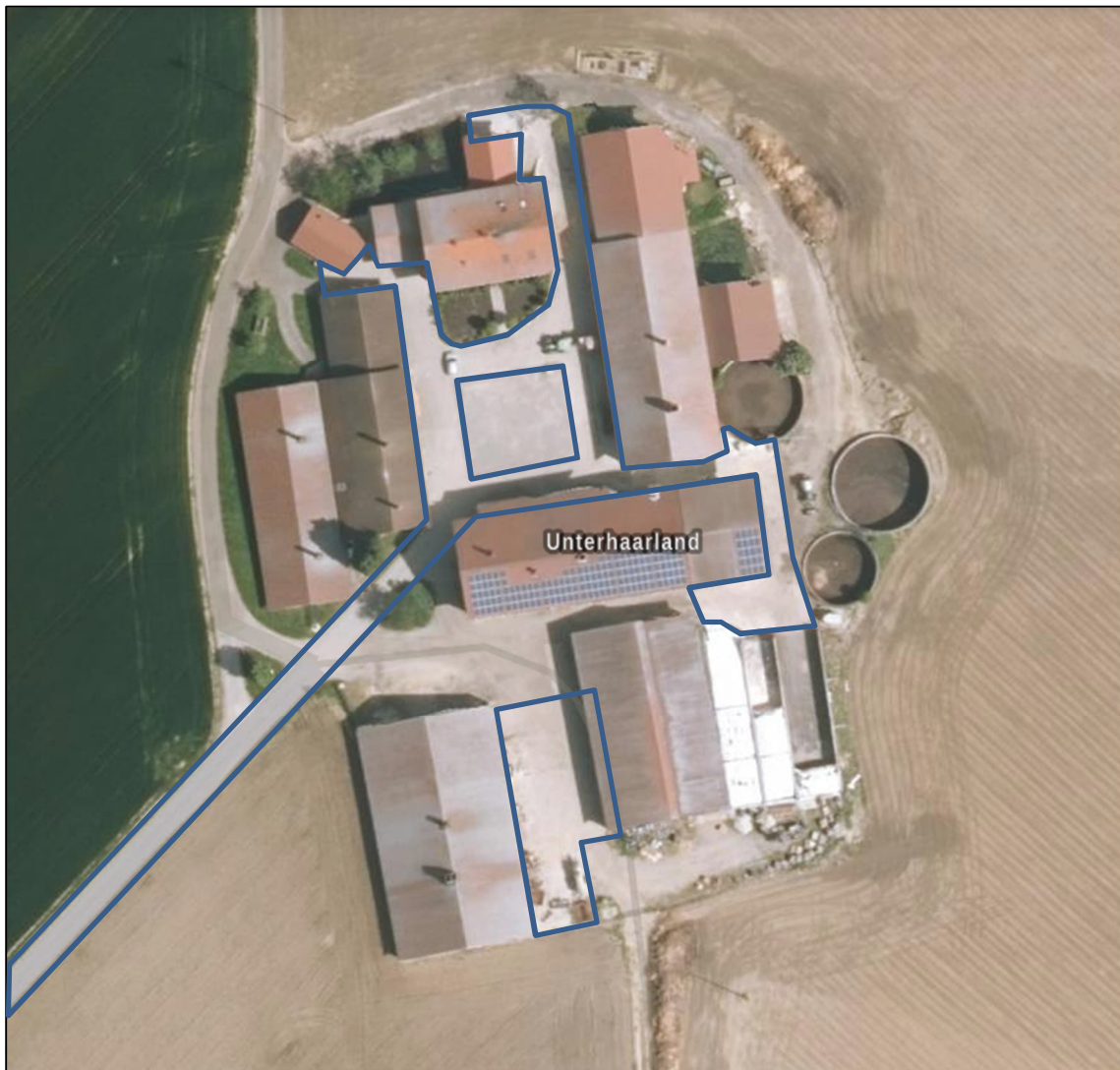
Abbildung 7: Luftbild des bestehenden Betriebs mit Kennzeichnung befestigter Verkehrsflächen (blaue Begrenzung), (Quelle Luftbild: BayernAtlas, Abruf am 03.07.2024)
