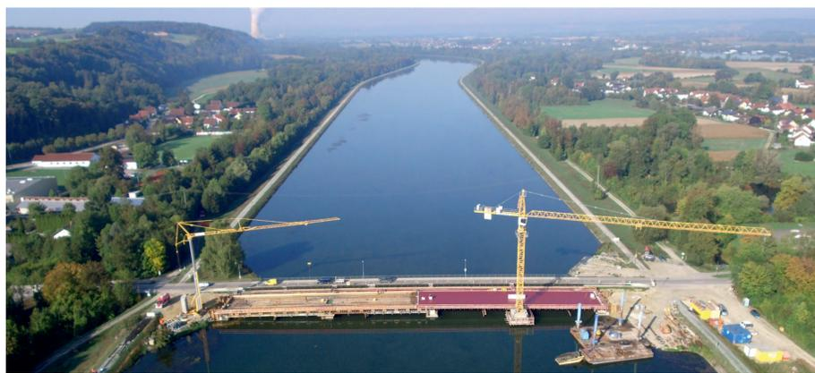
Während die alte Brücke (im Hintergrund) noch befahren werden kann, entsteht nebenan die neue, wesentlich breitere Brücke. Während auf der Lichtenseer Seite (rechts) der Überbau bereits fertig ist, erfolgen auf der Niederviehbacher Seite noch die Arbeiten für Schalung und Bewehrung.
