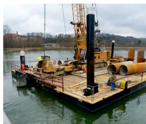
Herstellung der Pfähle für die künftigen Pfeiler von einem Schwimmponton aus, das extra für den Plan B aus den Niederlanden kam.
