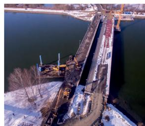
Abbruch des alten Bauwerks (links). Im Anschluss wird die neue Brücke 15 m flussaufwärts (nach links) „eingeschoben“.
