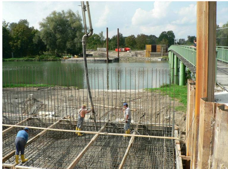
Betonieren des Widerlagerfundaments Seite Gottfrieding. Die Geh- und Radwegbrücke ist noch in Betrieb.
