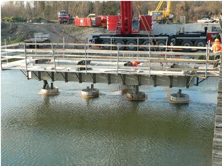
*Montage des Stahlbetonfertigteils auf den aus dem Wasser ragenden Stahlrohren der Flusspfeilergründung.*
