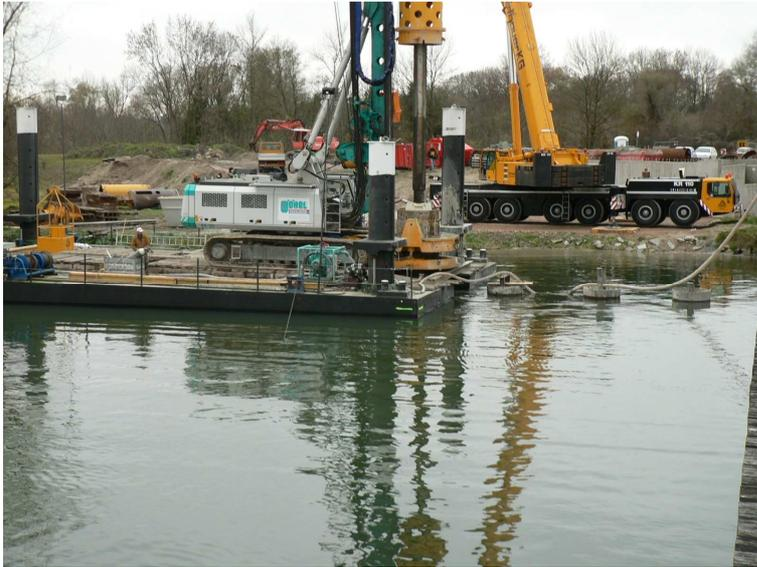
*Herstellung der Sondergründung im Fluss. Das 110 t schwere Bohrgerät der Fa. Wöhrl steht auf einem Stelzenponton.*
